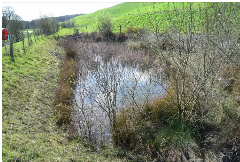
Bassin de rétention des eaux pluviales localisé à l'Est du projet
