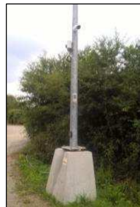
Photo 17 : Système de vidéo-surveillance avec détection infrarouge (à gauche) et du câble de détection (à droite) – photos prises sur les centrales solaires d'IEL à Machecoul (44) et à Descartes (37)
