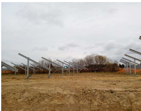
Photo 8 et 9 : Mise en place des pieux battus - photos de la construction de la Ferme Solaire Marc Energies, une réalisation IEL
