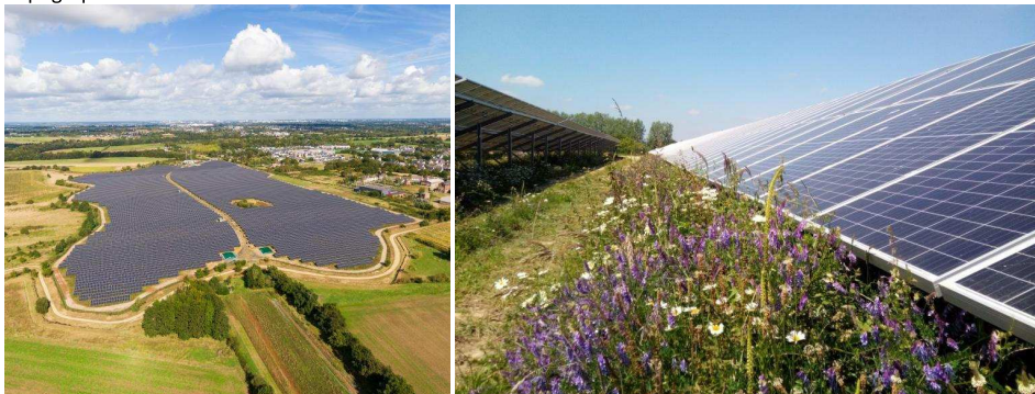
Photo 4 : Exemple d'installations fixes au sol : Centrale photovoltaïque de Bruz/Pont-Péan (Ferme Solaire Marc Energies, une réalisation IEL)
