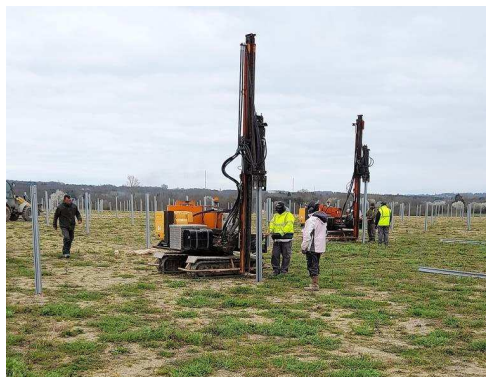
Photo 8 et 9 : Mise en place des pieux battus - photos de la construction de la Ferme Solaire Marc Energies, une réalisation IEL
