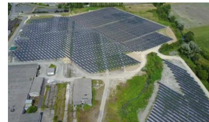
Ferme solaire Le Grignon – Descartes (37) Centrale solaire au sol de 6,25 MWc Mise en service : 2018
