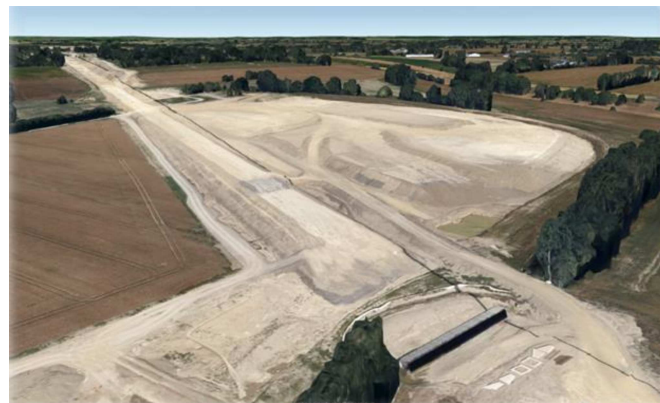
Photo 3 : Vue aérienne oblique du site projet en phase de travaux de la LGV (Google Earth)
