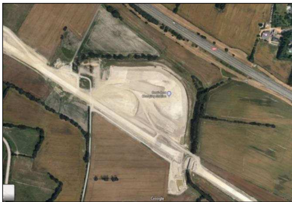
Photo 2 : Vue aérienne du site projet en travaux
