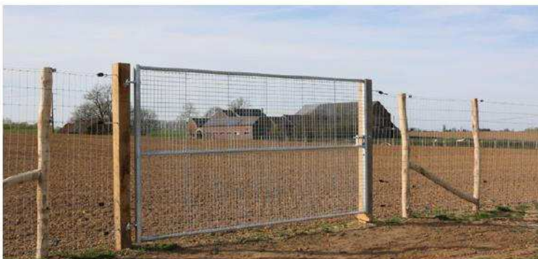
Photo 16 : Un choix de portail qui s'intègre discrètement dans un environnement rural- Exemple de portail en grillage gris
