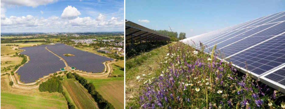
Photo 4 : Exemple d'installations fixes au sol : Centrale photovoltaïque de Bruz/Pont-Péan (Ferme Solaire Marc Energies, une réalisation IEL)
