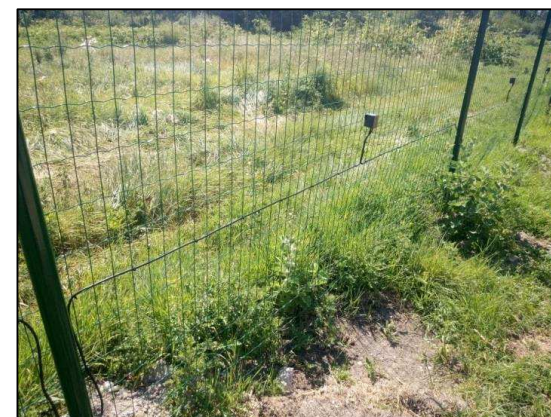
Photo 17 : Système de vidéo-surveillance avec détection infrarouge (à gauche) et du câble de détection (à droite) – photos prises sur les centrales solaires d'IEL à Machecoul (44) et à Descartes (37)
