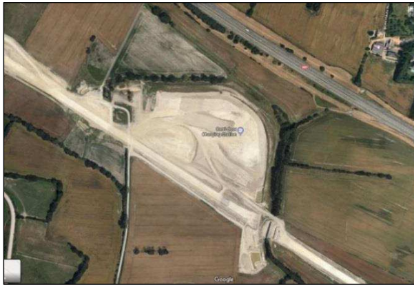
Photo 2 : Vue aérienne du site projet en travaux
