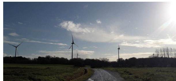
Parc éolien de Lamballe (22)
