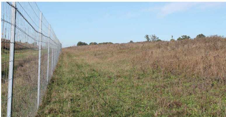
Photo 15 : Un choix de clôture qui s'intègre avec la clôture existante (Clôture utilisé en bordure de la LGV)
