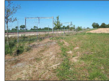
Photo 28 : Chemin situé à l'entrée du site
