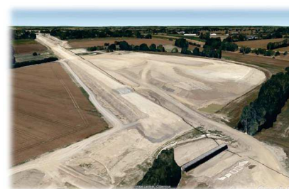
Vue aérienne oblique du site projet en phase de travaux de la LGV (Google Earth)
