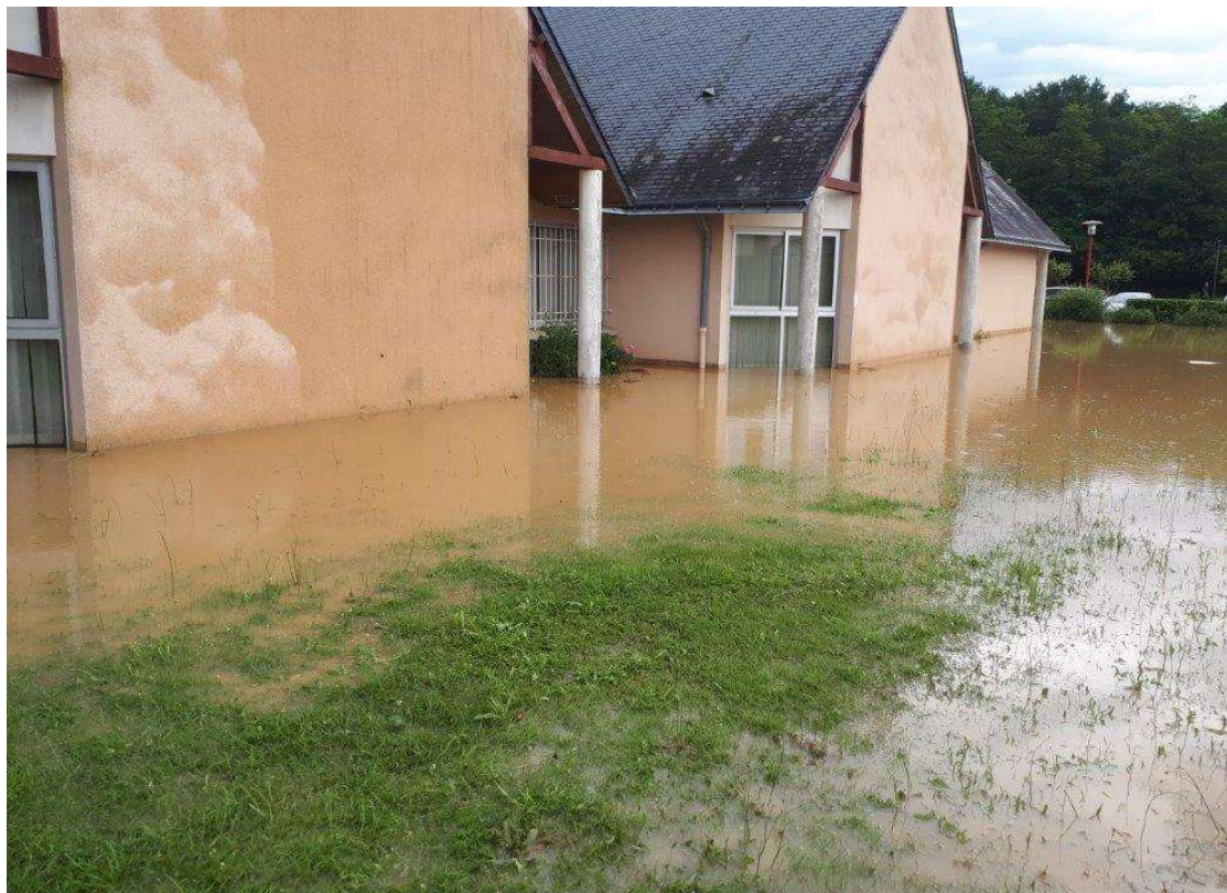
Photo 8: vue de l'extérieur de l'école primaire lors de l'inondation
