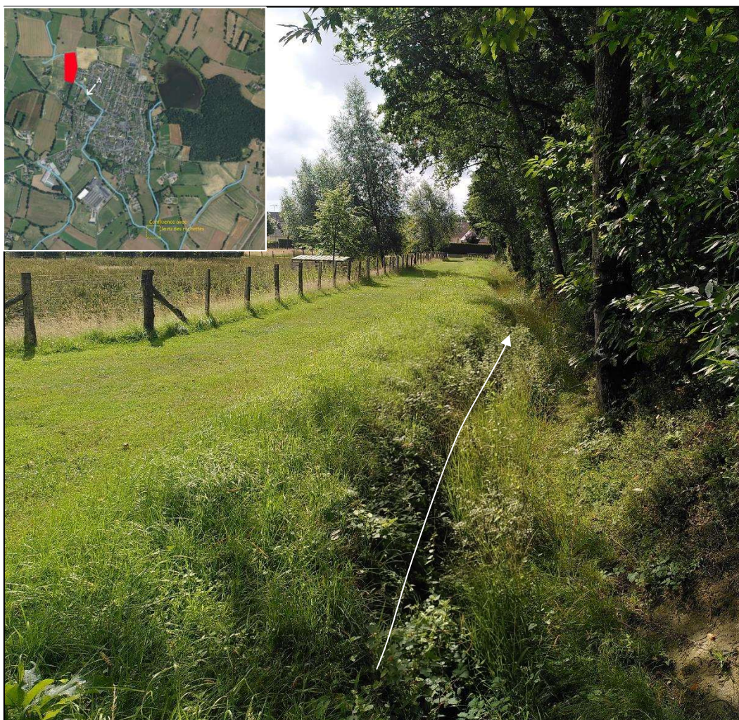
Photo 19: vue du cours d'eau en aval du site, à proximité des ouvrages hydrauliques du lotissement – juin 2022
