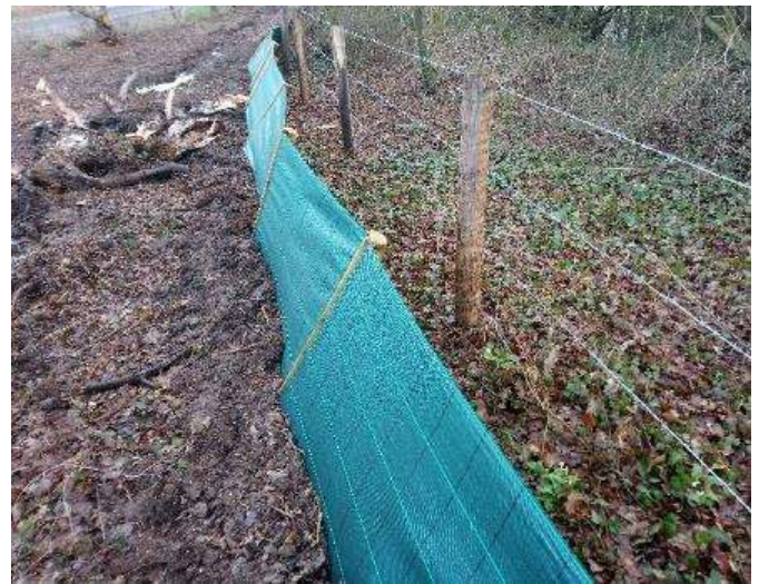
Photo 49: prise de vue d'une bâche de protection pour les amphibiens
