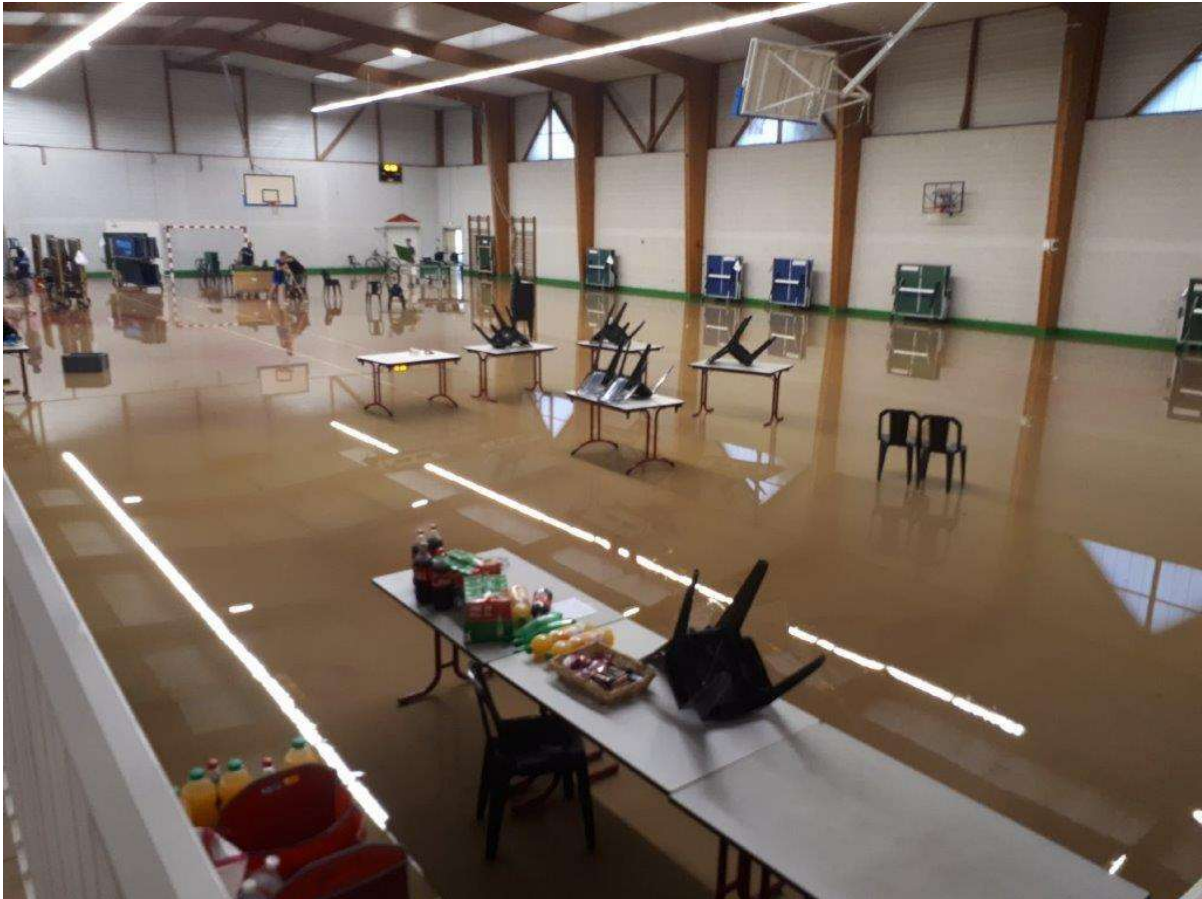
Photo 13: vue de l'intérieur de la salle omnisport lors de l'inondation
