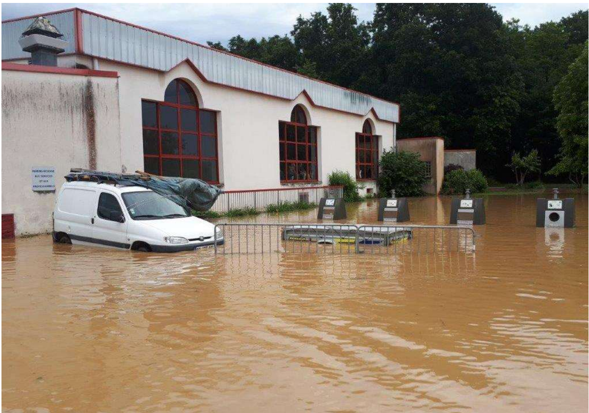
Photo 12: vue de l'extérieur de la salle omnisport lors de l'inondation
