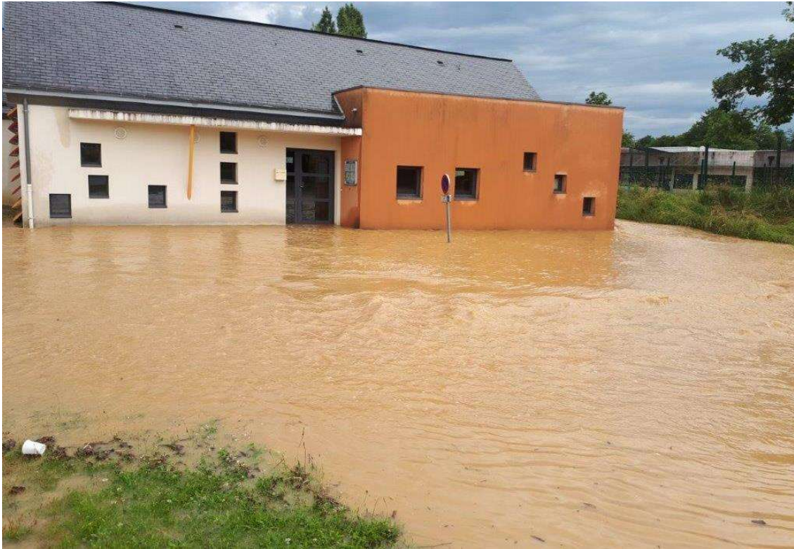
Photo 3: vue centre multiaccueil et parking lors de l'inondation
