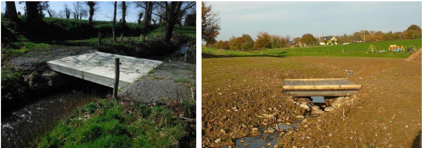
Photo 15: Exemples de passerelles aménagées – Source : Hardy Environnement - Syndicat du bassin de l'Oudon
