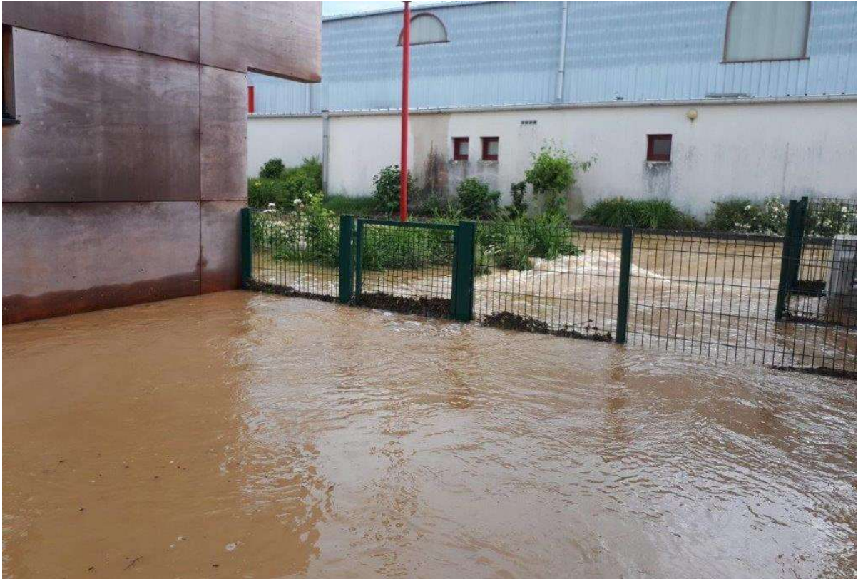
Photo 11: vue du ruissellement entre la salle et l'école lors de l'inondation
