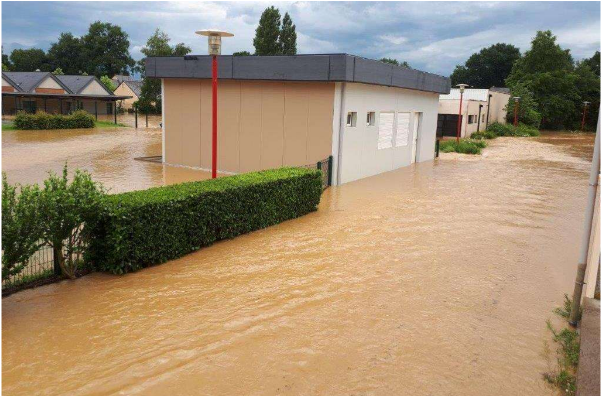
Photo 1: vue des bâtiments scolaire lors de l'inondation
