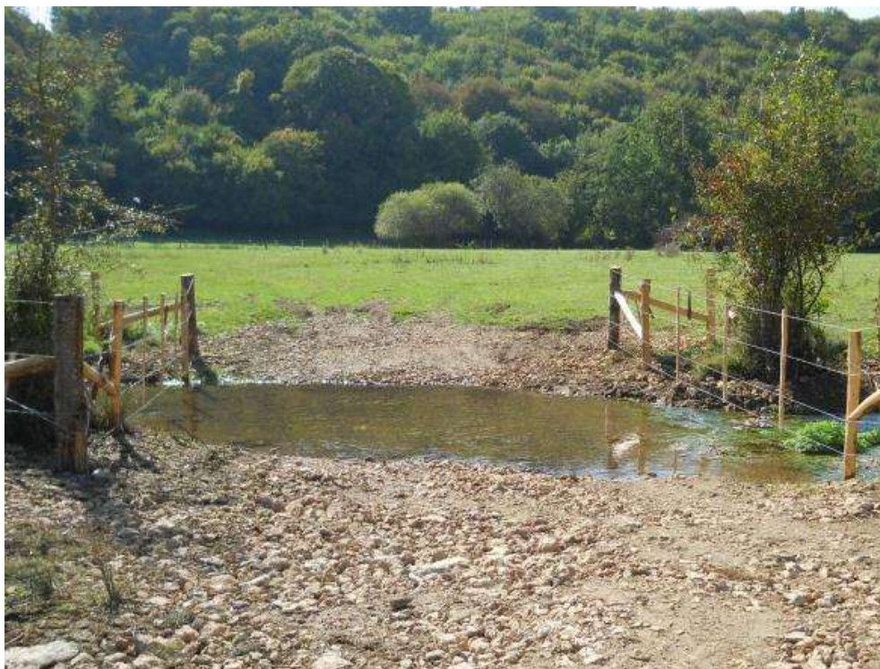
Photo 16: Exemple de passage à gué aménagé
