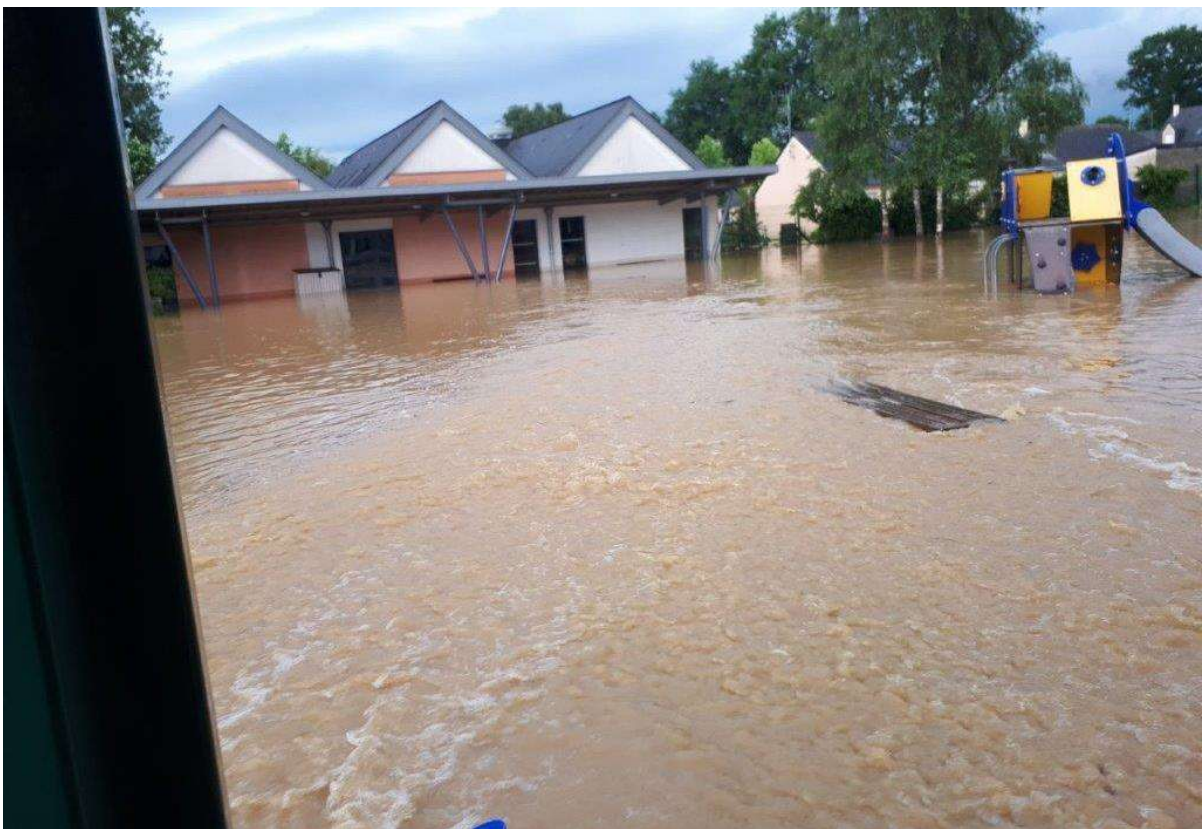
Photo 2: vue du centre multi accueil et de la cour lors de l'inondation
