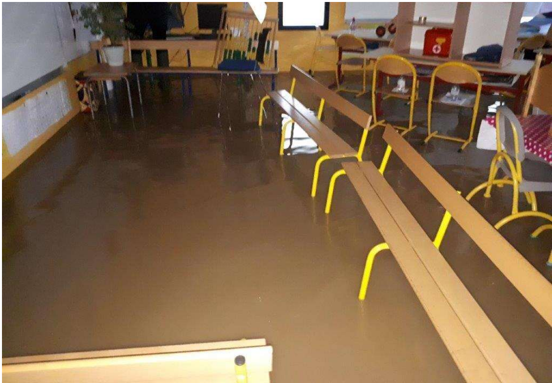
Photo 4: vue de la classe de primaire lors de l'inondation
