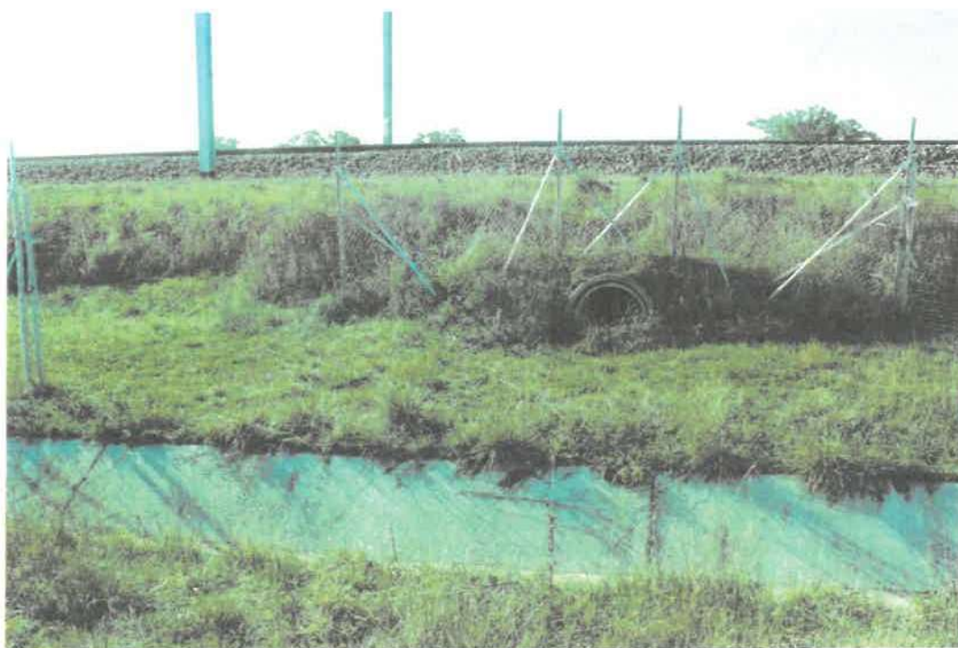
Figure 5 : Buse pour le passage de la petite et moyenne faune sous la LGV
