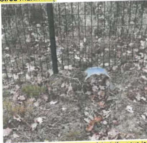
Exemple de passage faune moyenne à installer sous la clôture
